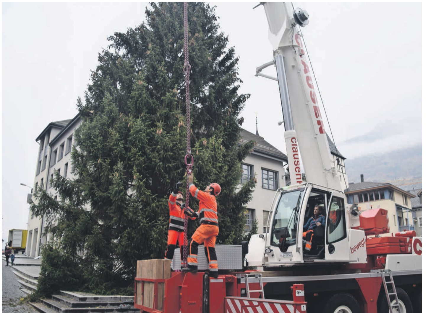
Mit dem Kran. Aufstellarbeiten des Weihnachtsbaums auf dem Stadtplatz.
